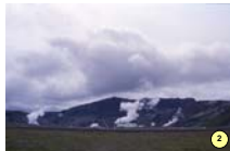
Central geotérmica de Nesjavellir que bombea el agua a 84°C hacia Reykjavik y otros siete municipios de su entorno.
